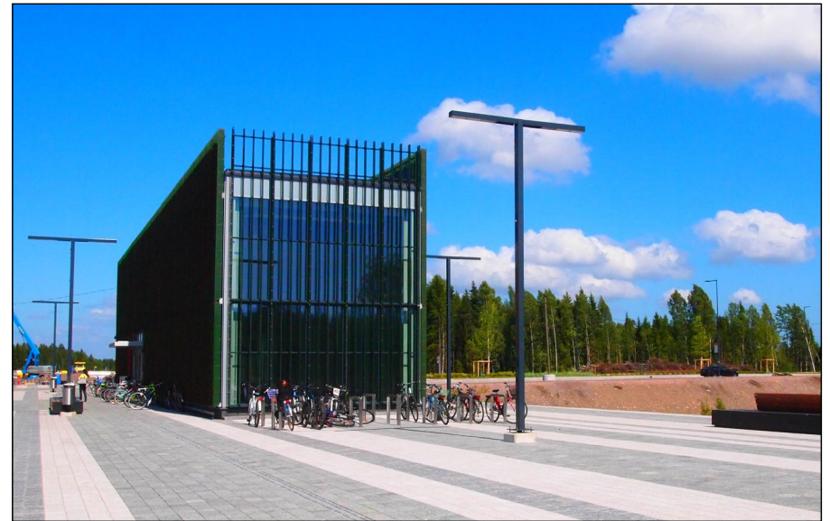
Kivistön uusi rakentuva keskusta sijaitsee hyvien liikenneyhteyksien varrella. Kuvassa Kehäradan Kivistön asema.
