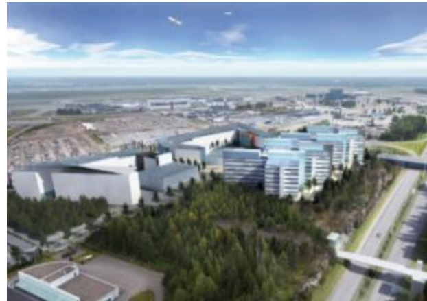
Toimistorakentamista Karhumäentielle. Arkkitehtitoimisto Sarc Oy 2011.
