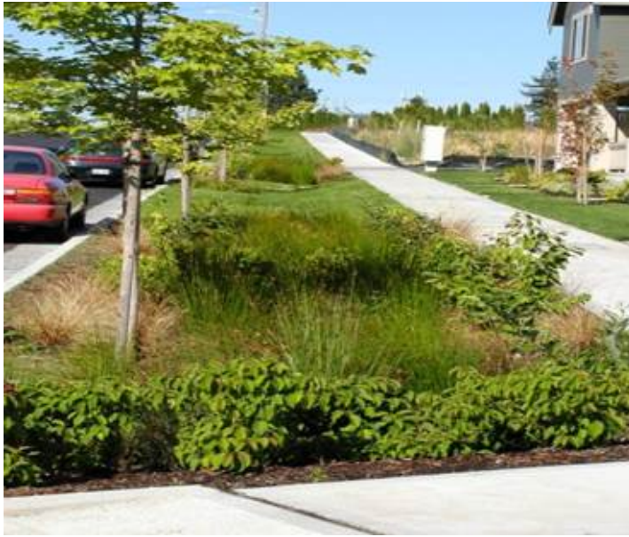
Kuva 8 Valokuva viher-/hulevesien viivytyspainanteesta Portlandista (alla).
