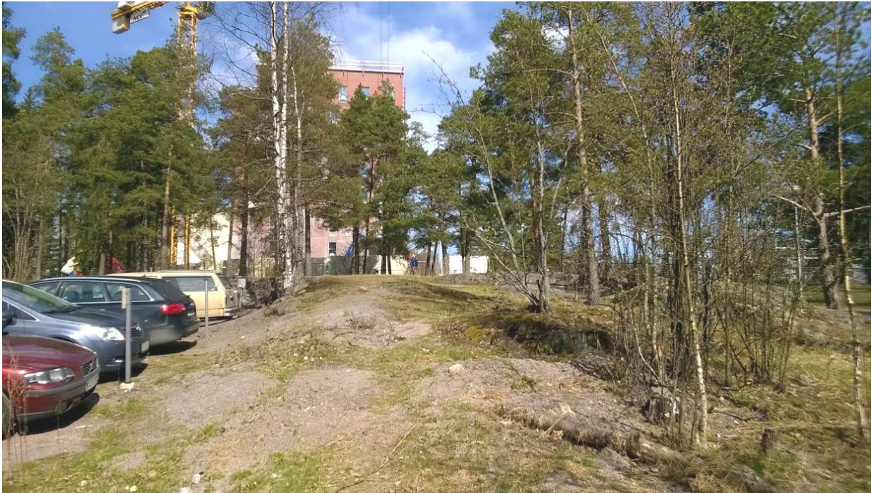
Rakennuspaikka, Virtakuja 4:n tontin yläosaa. Kallio on lähellä maan pintaa.
