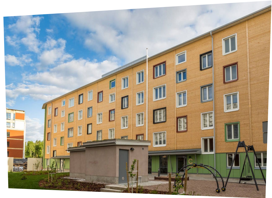
Puurakentamista Kivistössä. Kuvaaja: Sakari Manninen
