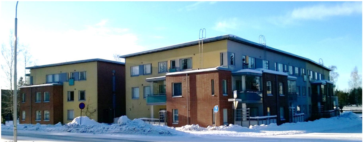
Kierretie 2 – 4:n kerrostalot valmistuivat 2010. Julkisivut ovat pääasiassa ohutrappausta ja osin tiililaattaa. Optiplan Arkkitehdit.
