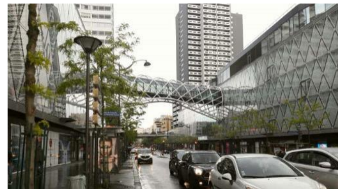
Kuva 121. Lähes 50 000m 2 kokoinen Beaugrenellen kauppakeskus Pariisissa on osin uutta rakentamista, osin sijoitettu uudistettuun v. 1979 rakennettuun ostoskeskukseen. Alue on kehitetty sekoittuneen kaupunkirakenteen kaupunginosaksi, jossa kohtaavat toimistot, hotellit, palvelut ja asuintornit.
