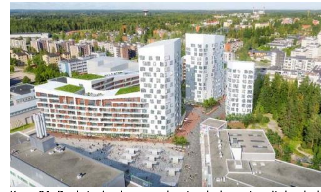
Kuva 91. Paalutorin viereen rakentuu kolmen tornitalon kokonaisuus
