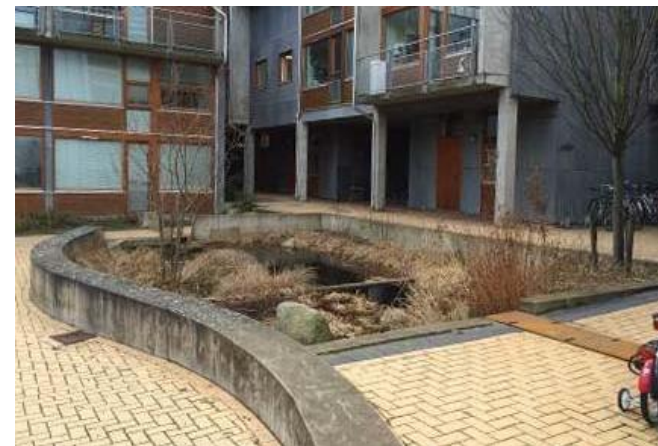
Kuva 55. Hulevesien viivytysallas pihalla.
