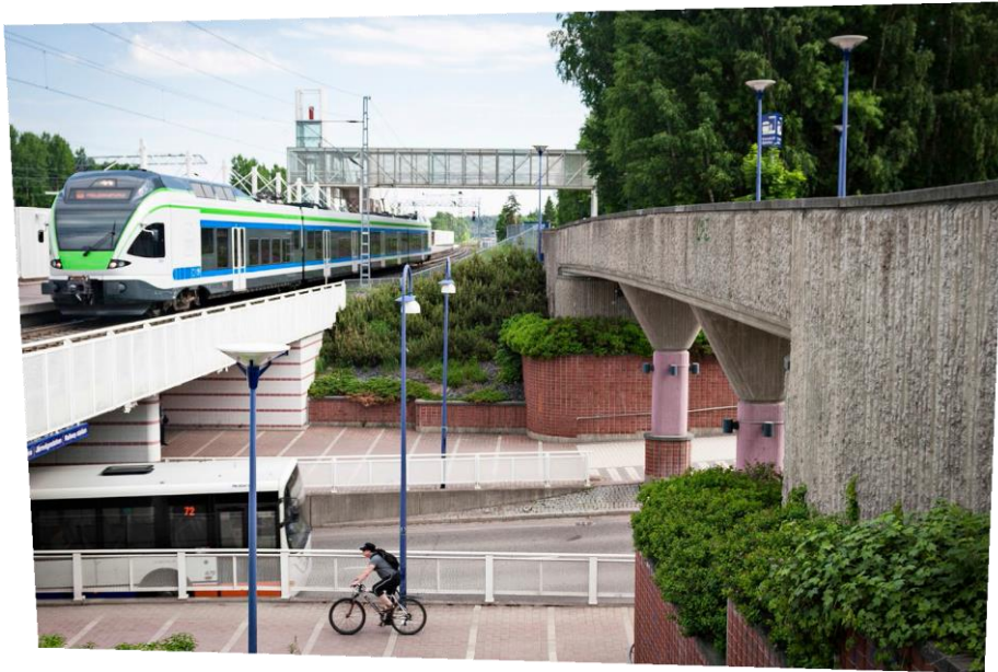
Ilmastoystävällistä liikkumista Vantaalla. Kuva: Vantaan kaupunki
