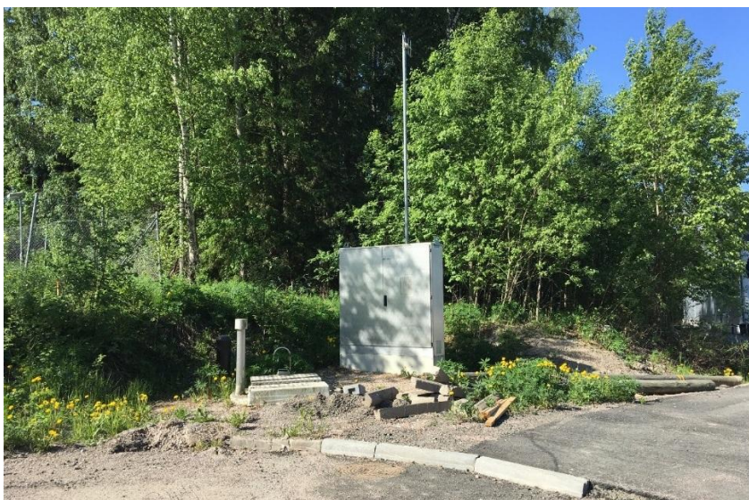
Tontin 41270-10 rajalla on sähkökaappi ja jätevesipumppaamo, mikä estää tonttiliittymän rakentamisen.
