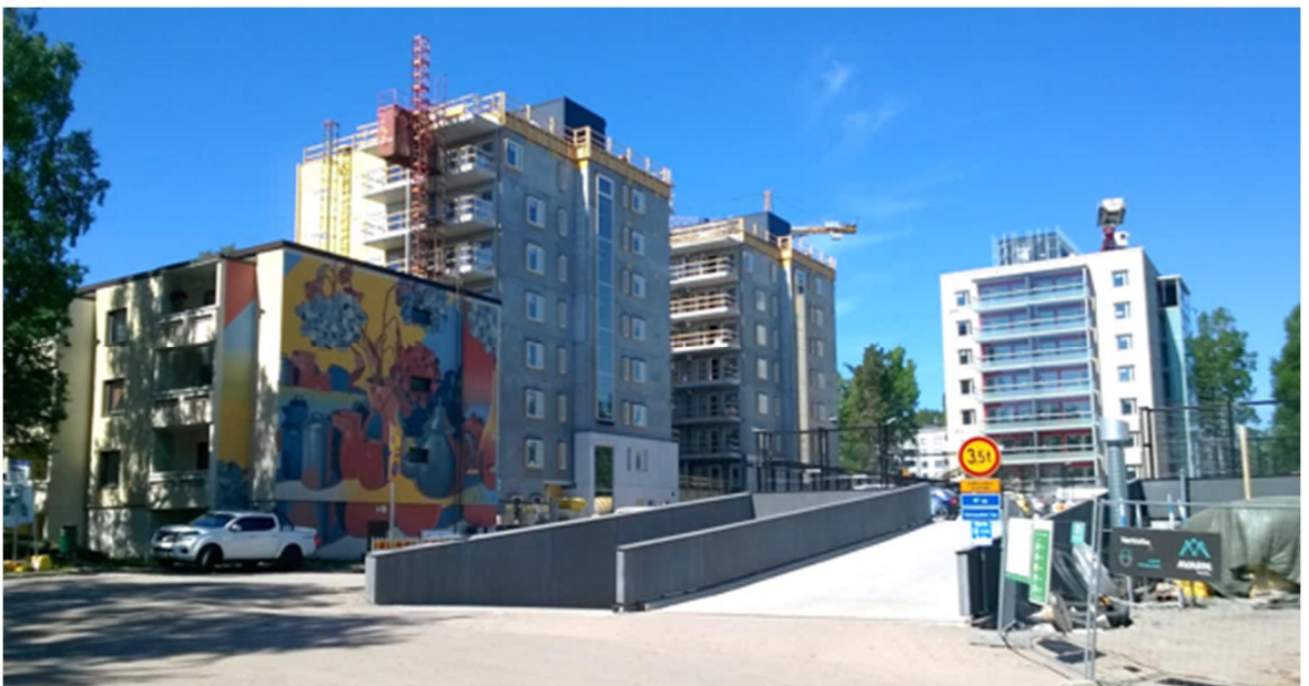
Talot rakenteilla. Oikeanpuoleisin torni valmistui syyskuussa 2018.
