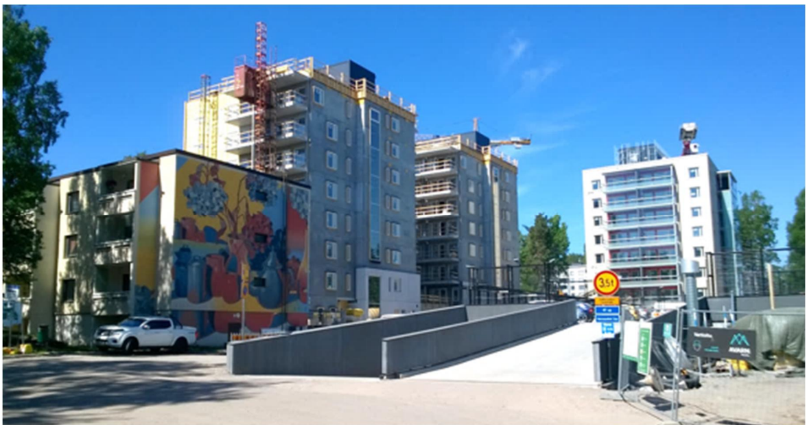
Talot rakenteilla. Oikeanpuoleisin torni valmistui syyskuussa 2018.
