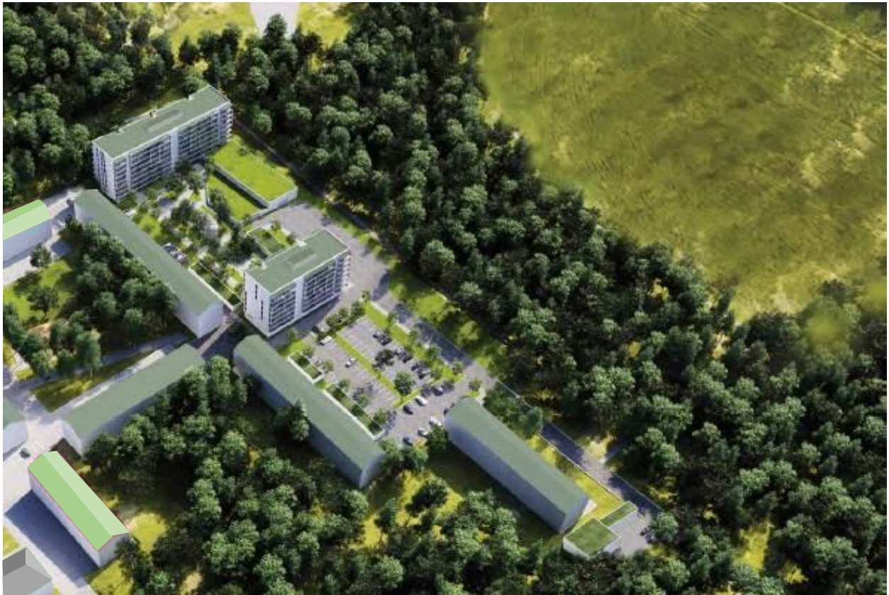
Uudistakentaminen Haltiantielle, näkymä etelästä.
