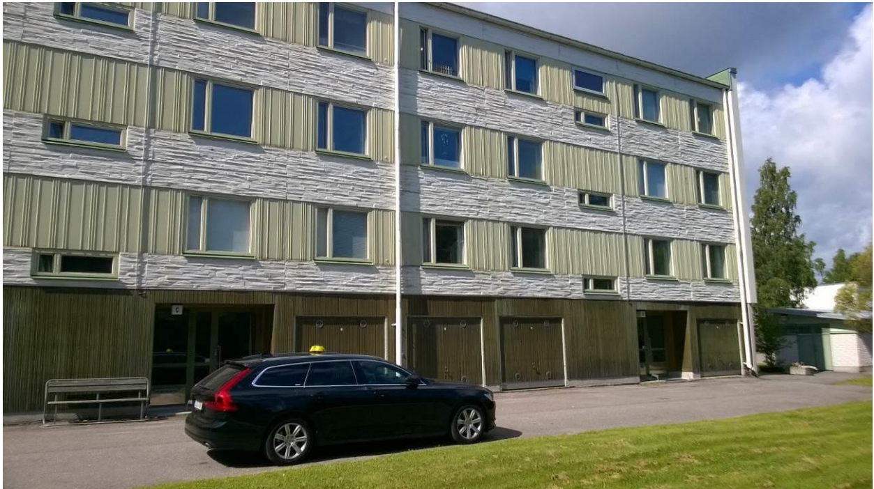
Haltiantie 4. 1960-luvun taloissa on reliefijulkisivut. Väritys on 1990-luvulta.
