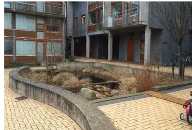
Kuva 56. Hulevesien viivytysallas pihalla.
