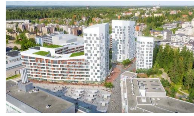
Kuva 93. Paalutorin viereen rakentuu kolmen tornitalon kokonaisuus
