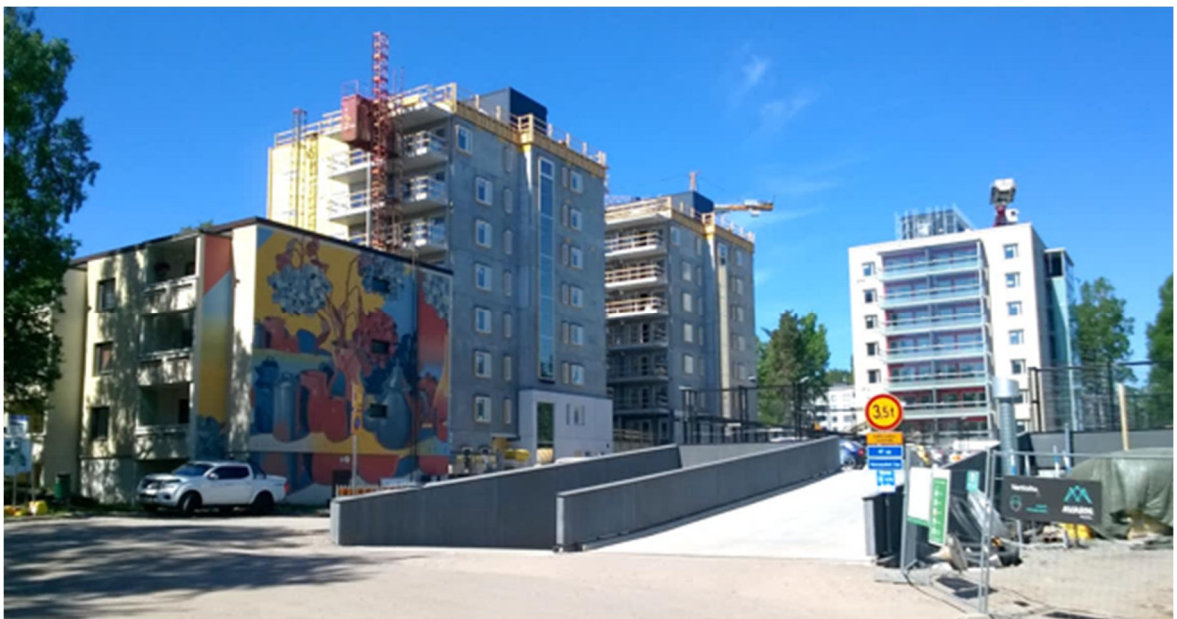
Talot rakenteilla. Oikeanpuoleisin torni valmistui syyskuussa 2018.
