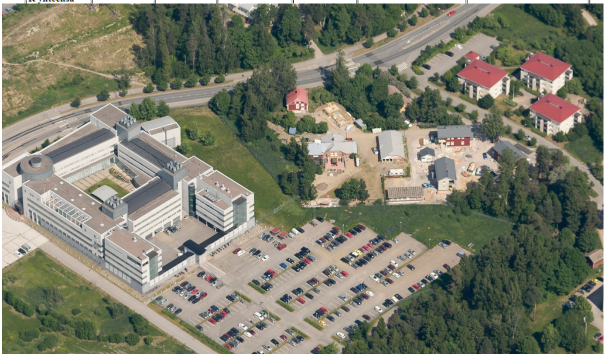
Ilmakuvassa vuodelta 2011 talousrakennuksia ollaan vasta rakentamassa.
