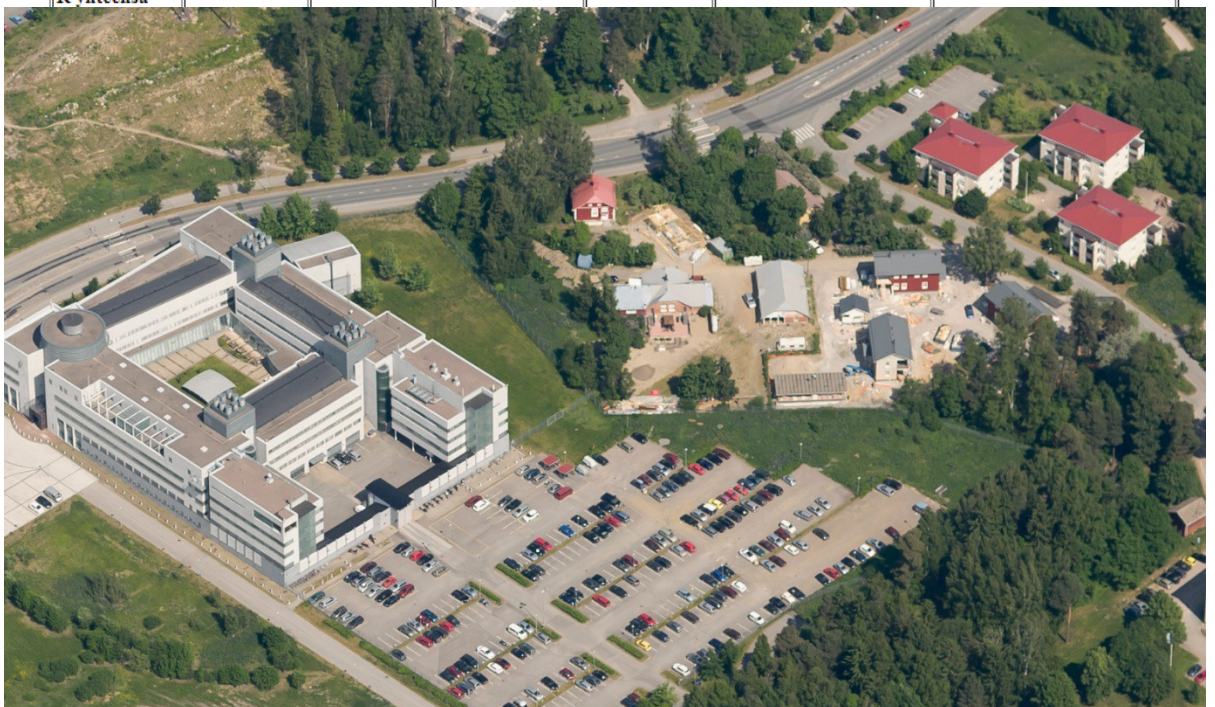
Ilmakuvassa vuodelta 2011 talousrakennuksia ollaan vasta rakentamassa.
