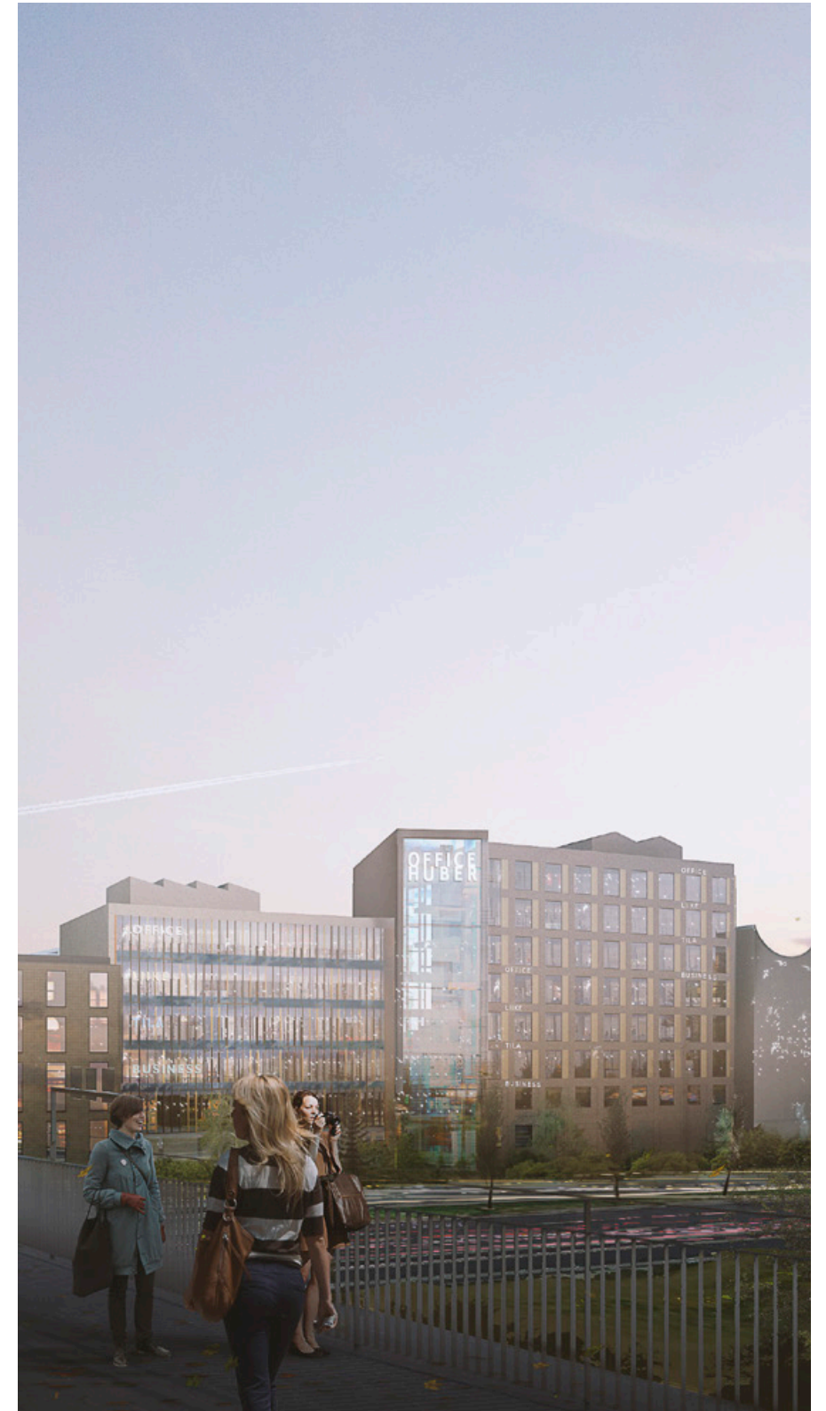
Kuva 16b. Näkymä toimistorakennukselle Tikkurilantien sillalta.
