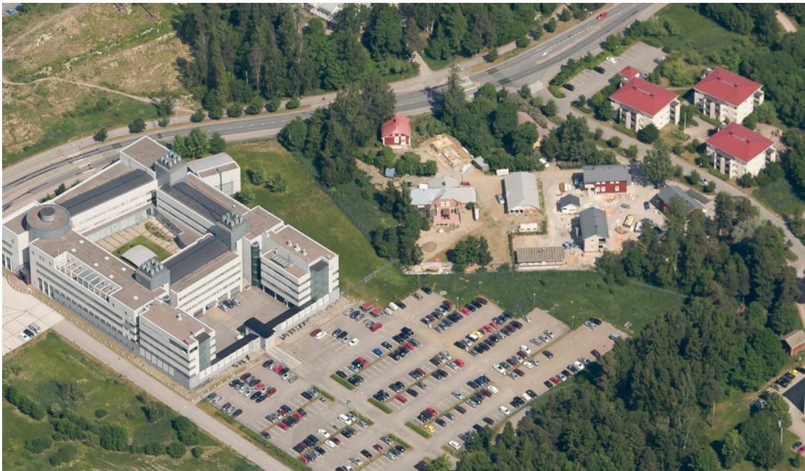
Ilmakuvassa vuodelta 2011 talousrakennuksia ollaan vasta rakentamassa.
