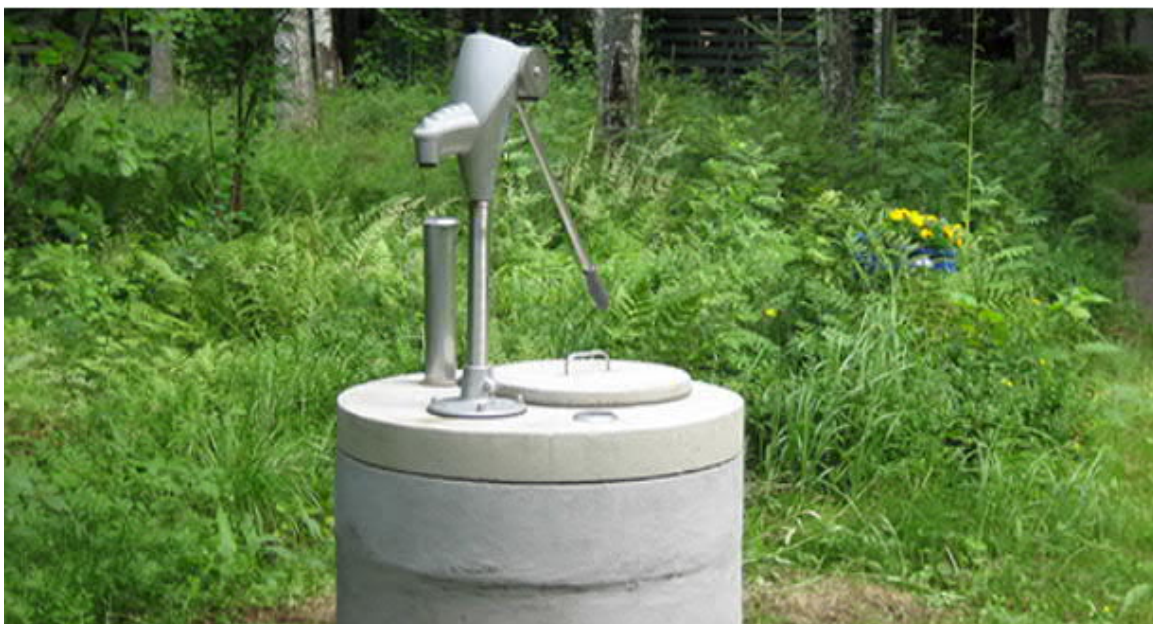
Kuva 5. Kunnostettu rengaskaivo ja käsipumppu veden nostamiseen (Erkki Santala, SYKE)
