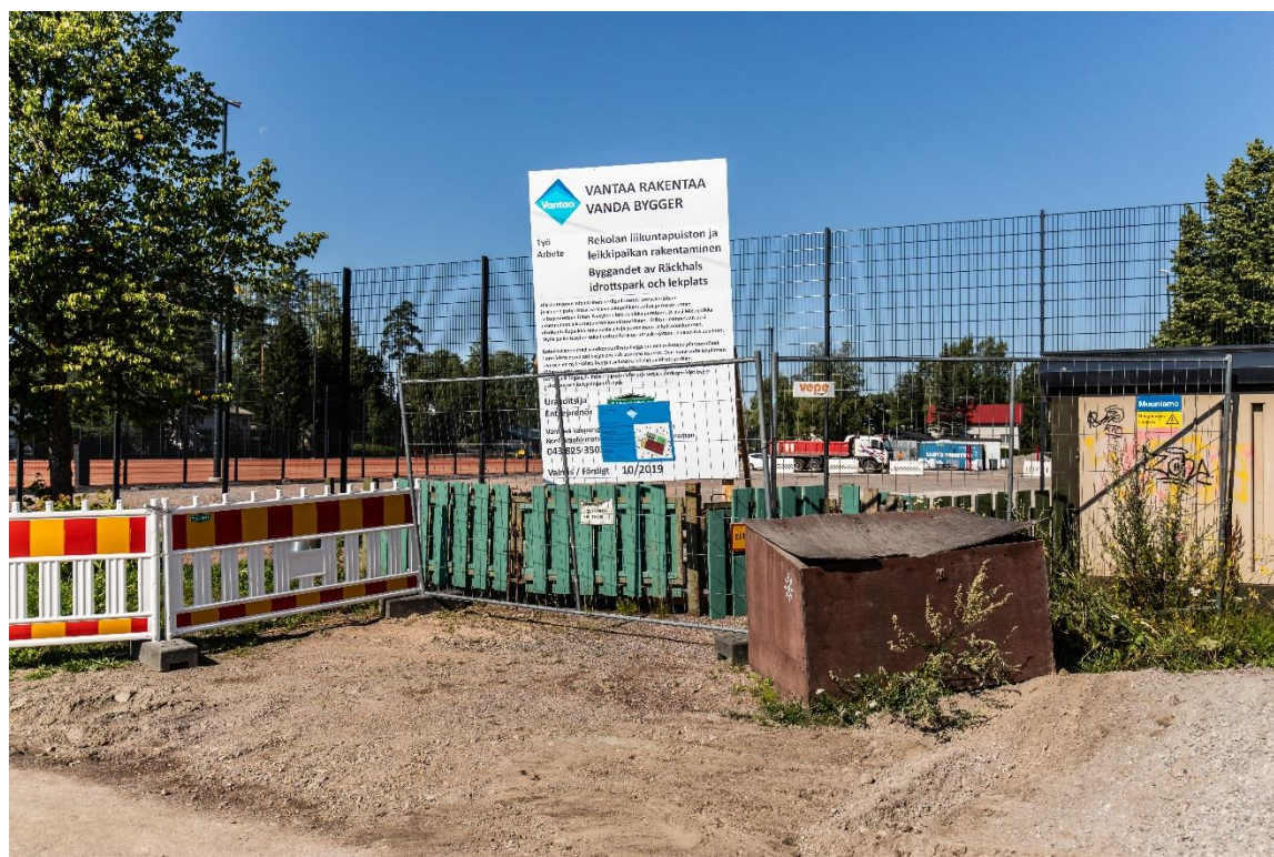
Rekolan liikuntapuistoa rakennettiin 2019. Kuva: Ilari Lehtinen.
