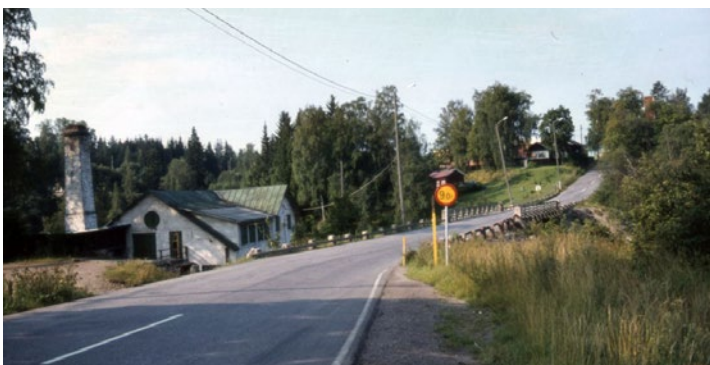
Kuninkaantie kulkee läpi Vantaan itä-länsi-suunnassa. Yksi tunnettu maisema, jonka läpi tie kulkee, on Vantaankoskella. Kuva: Erkki Ala-Könni / Vantaan kaupunginmuseo.
