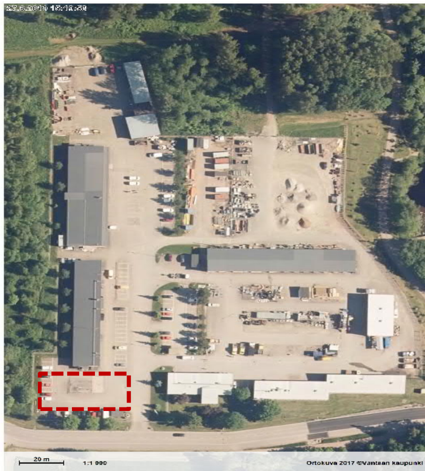
Kuva 2. Ilmakuva Koisotie 7, rakennuspaikan sijainti esitetty punaisella viivalla.
