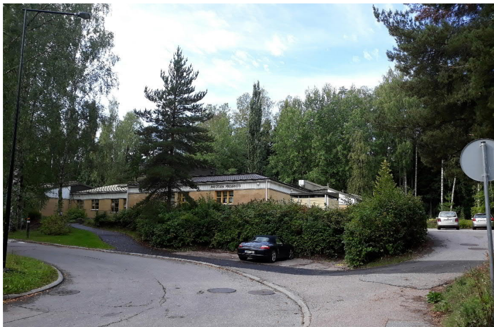
Kuva 6: Näkymä tontille Patotieltä. Näkyvä rakennus on olemassa oleva päiväkotito, jonka paikalle tuleva päiväkotito on tarkoitus toteuttaa. Kuva Courtemanche 3.9.2019.
