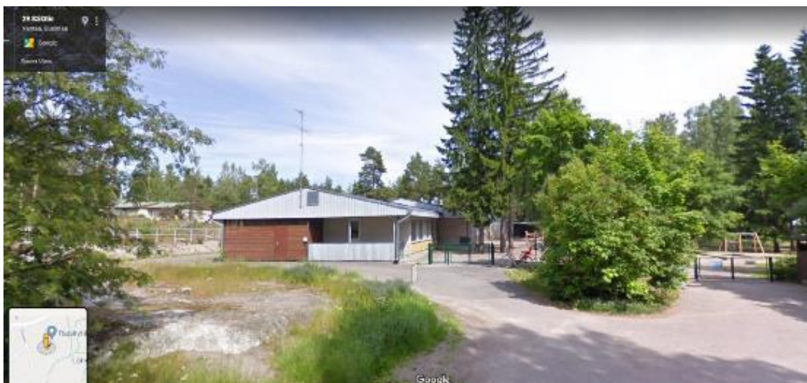
Kuva 7. Näkymä tontille, kuvassa purettava Rajakylän päiväkotirakennus. Googlemaps 16.4.2020
