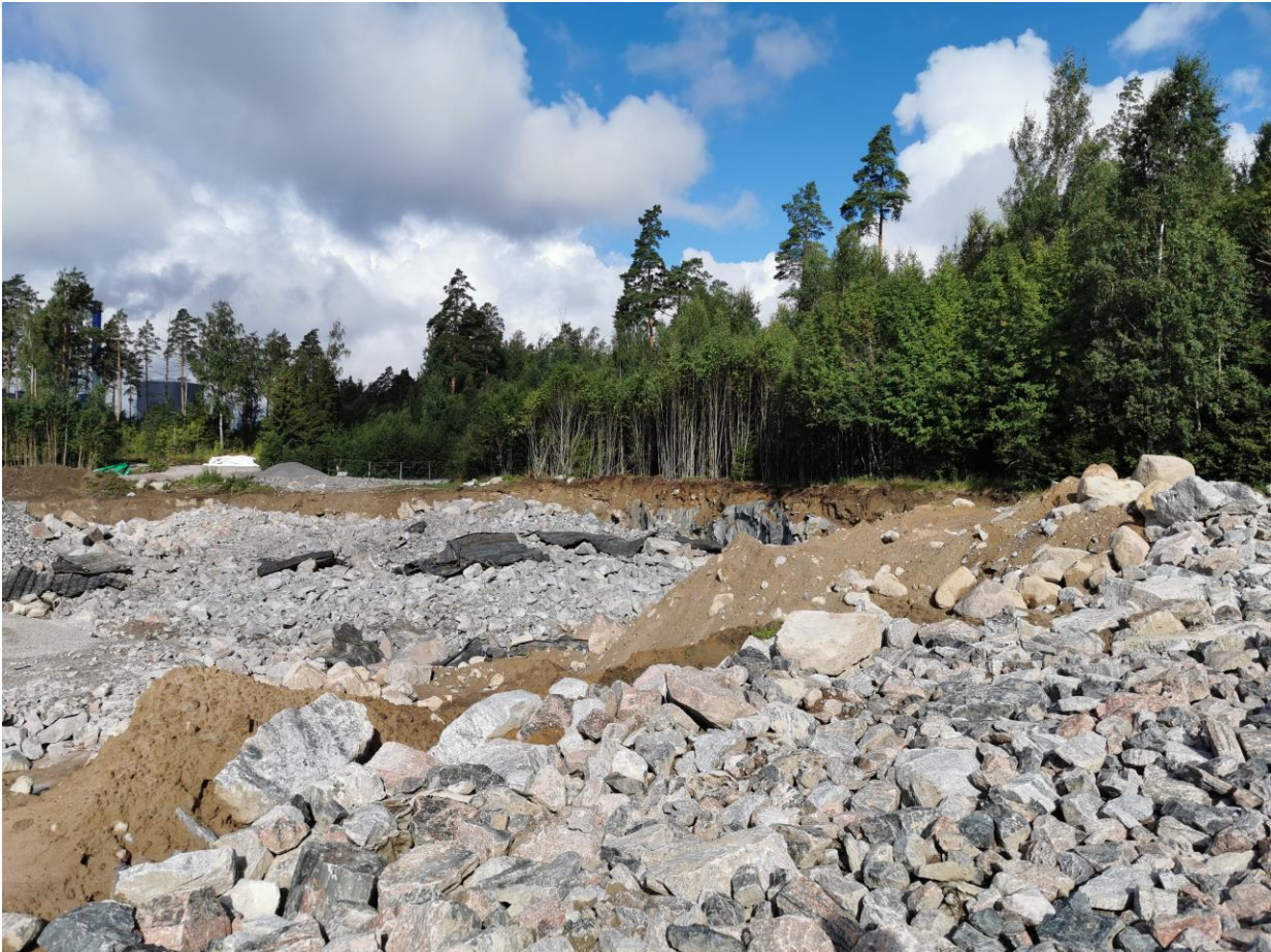
Kuva 2. Kiinteistön pohjoisreunasta jouduttiin louhimaan kalliota pois.
