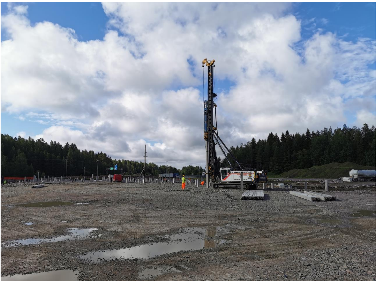
Kuva 1. Työmaalla oli tarkastushetkellä käynnissä paalutus
