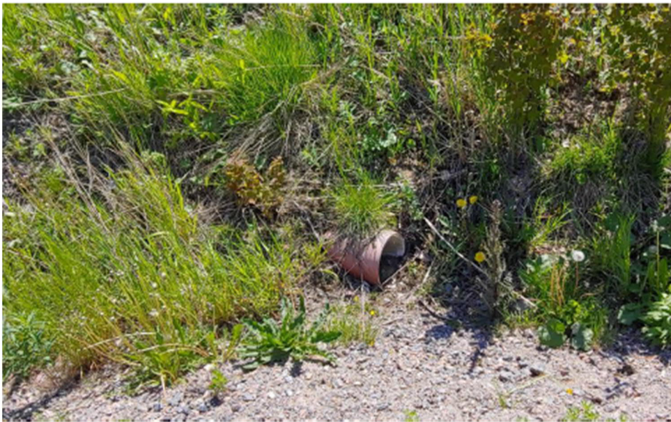
Kuva 4. Putkitetun ojan loppupää Viittatien puolella
