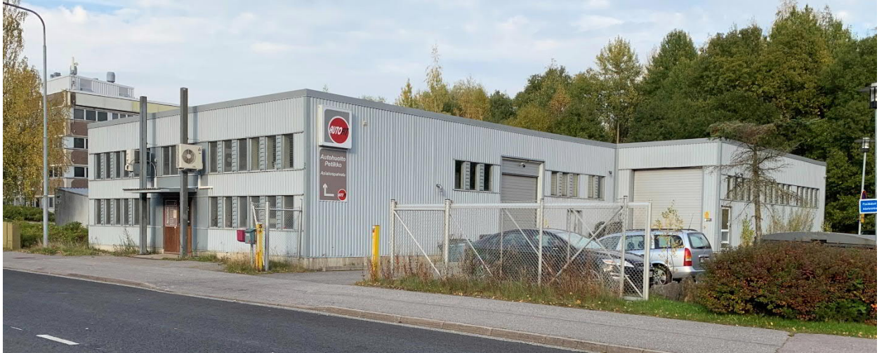
Näkymä Tiilenpolttajankujalta. Tontilla toimii autohuolto ja korjaamo.
