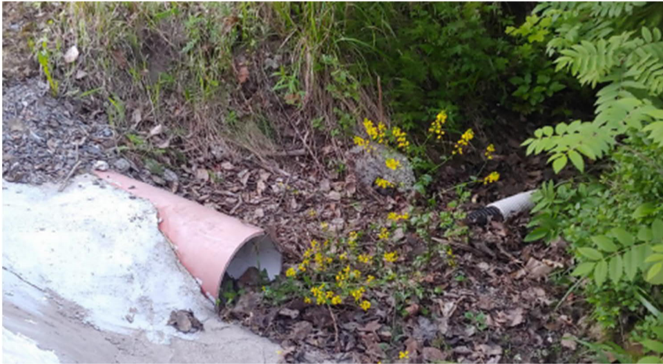
Kuva 3. Putkitetun ojan alkupää Vieteririnne 4:n itäpuolella
