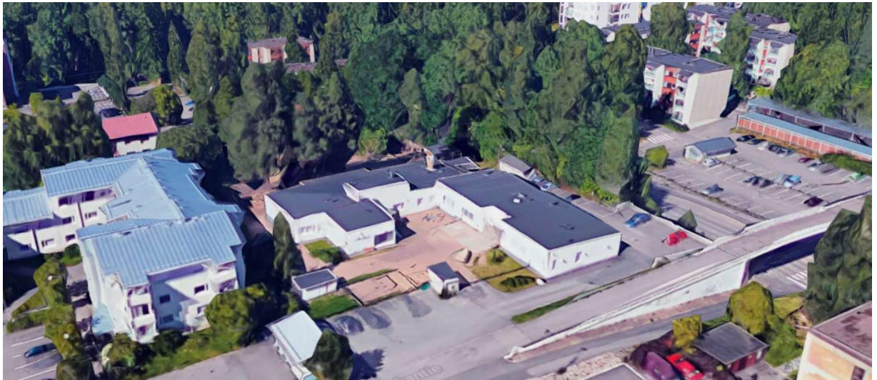
Kuva 1. Tontilla sijaitsee tyhjiään, olemassa oleva päiväkotikoti.
