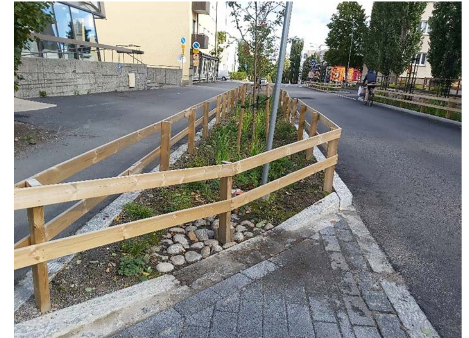
Kuva 35. Esimerkkikuva Jyväskylän Puutarhakadun biosuodatusrakenteista. Vedet ohjataan rakenteeseen alaslasketun miinusreunakiven kautta. Parkkialueella läpäisevä kiveys, josta pintavaluntavedet kulkevat reunassa matalampana olevan kiveyksen kautta kourun taan. Suojakaiteet ovat alkuvaihetta varten, poistetaan.
