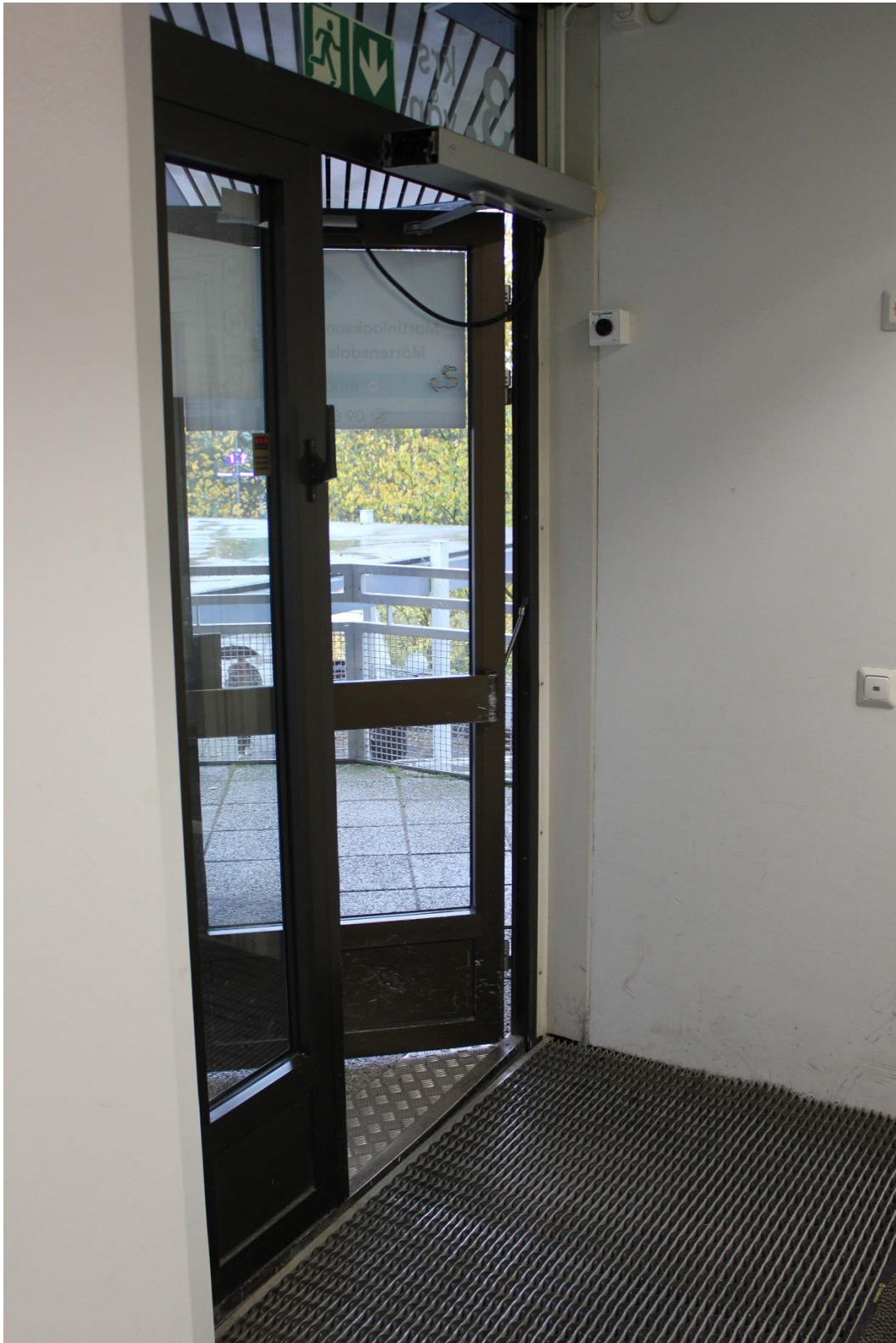
Kuva 3.2.1 Kolmannen kerroksen oven sisääntulo
