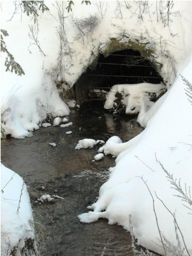
Kuva 12. Rumpu kehä III:n alituksessa on aidattu harvoilla tangoilla, jotka eivät kuitenkaan estä saukkojen kulkua.
