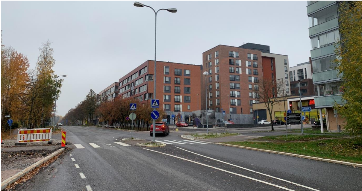
Kuva 3. Esimerkki keskisaarekkeellisestä suojatiestä.
