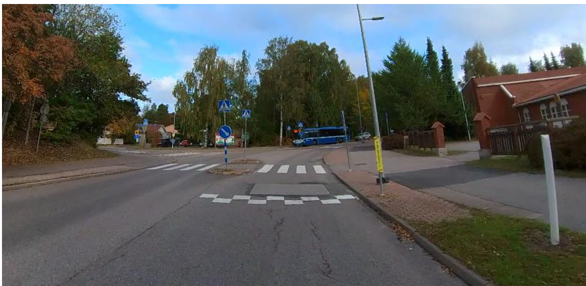
Kuva 8. Epinkoskientien suojatie varustettu keskisaarekkeella ja tyynyhidasteella.
