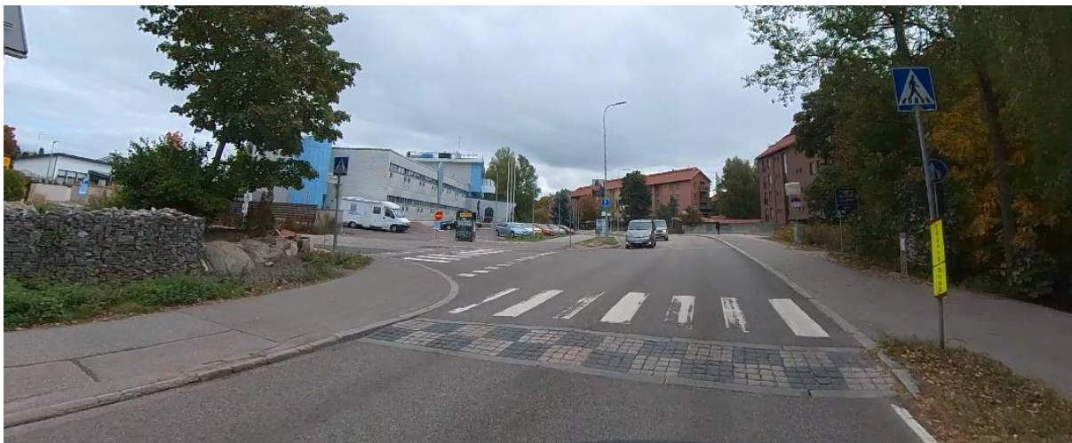
Kuva 11. Korotettu liittymä Ylästöntie - Veromäentie.
