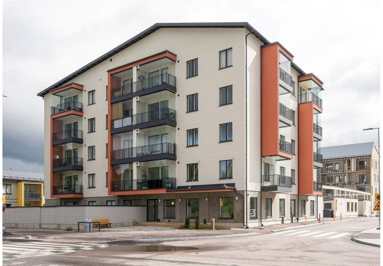
Skanska Boklok, Peltolantie 35, Tikkurila 2020 . Puurunko (tolppa), vaakaverhoilu puu. Rakennuttaja Boklok / Skanska Talonrakennus Oy, Arkkitehti Mikko Rosti
