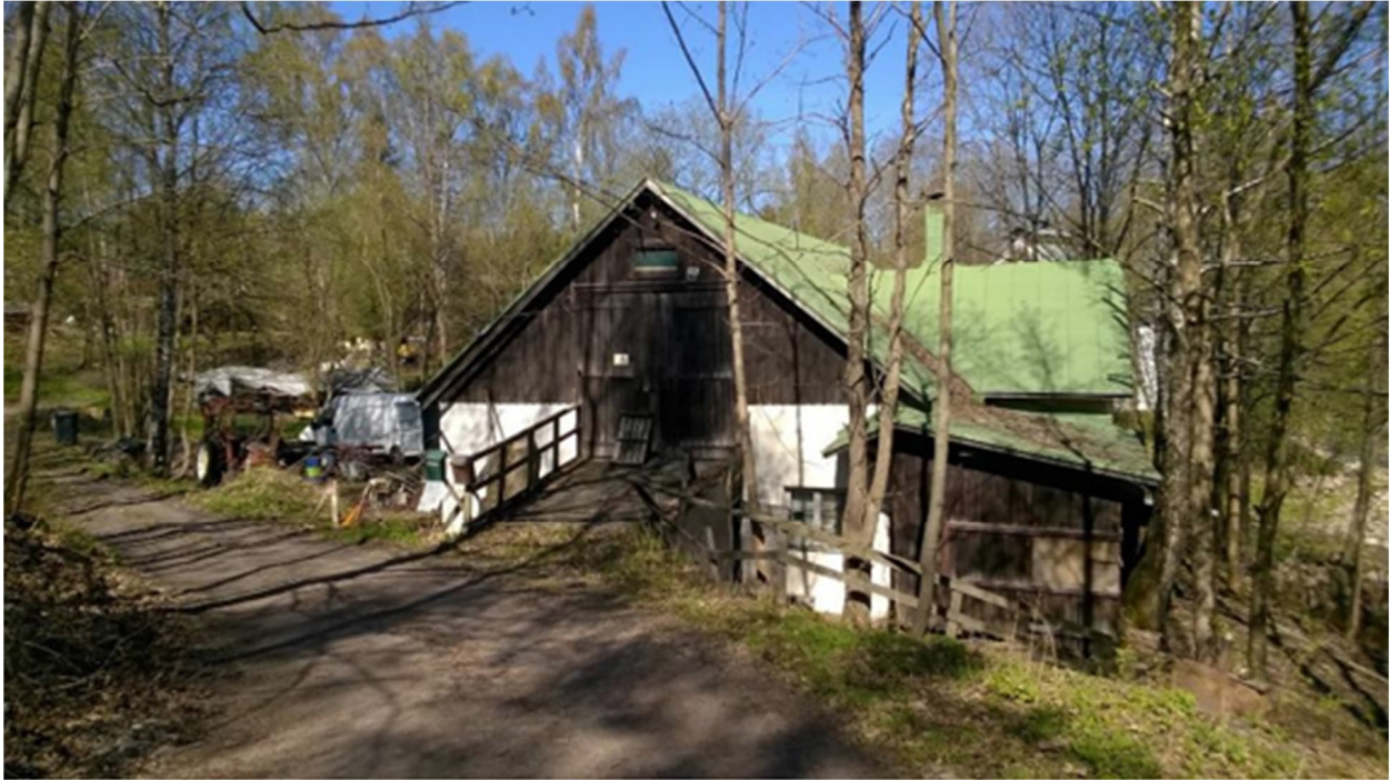
Vanha navetta/varasto sijaitsee masuunin paikalla ja puretaan.
