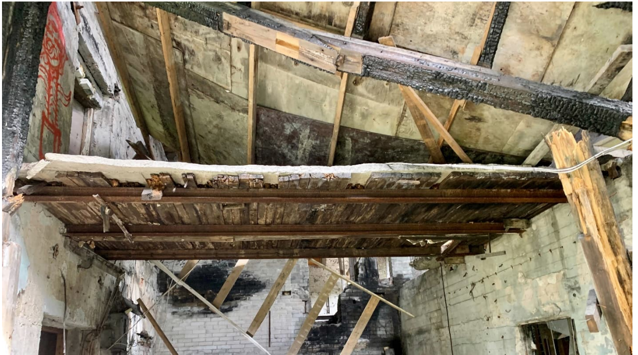
Myllyn katto on tehty väärin, palkki on haljennut ja katto romahtanut. Sisällä ollut tulipalo jälleen elokuussa 2021. Korjattuna salista tulee juhlatila. TKa 20.8.2021
