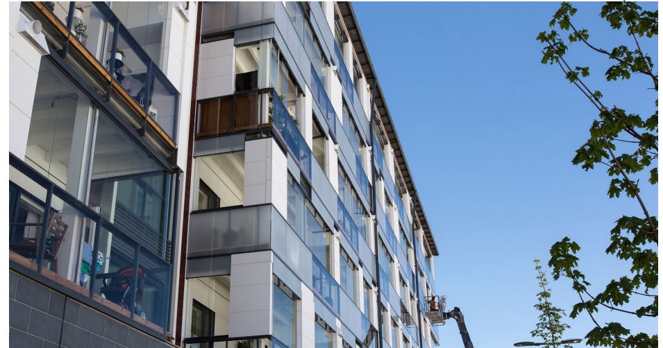
PuuMera, valmistuessaan Euroopan suurin asuinkäyttöön tarkoitettu puukerrostalo. Kivistö 2015. Ensimmäinen kerros betonirakenteinen, ylemmät kerrokset puurakenteisia, puurunkojärjestelmänä käytettiin rankarakenteisia suurelementtejä. Arkkitehtitoimisto Vuorelma Arkkitehdit Oy
