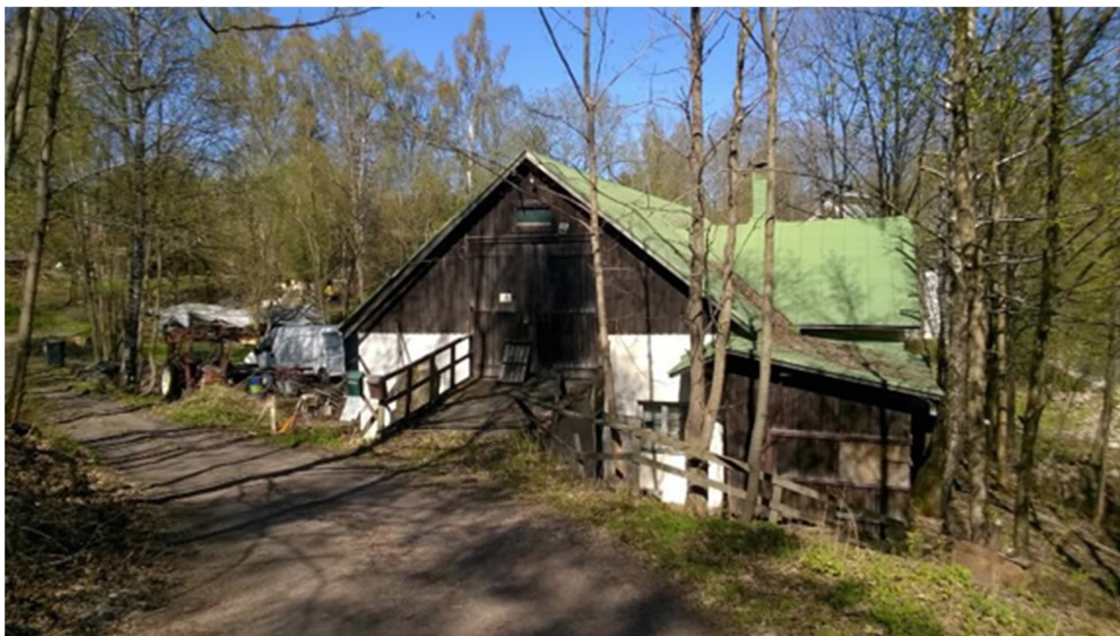
Vanha navetta/varasto sijaitsee masuunin paikalla ja puretaan.
