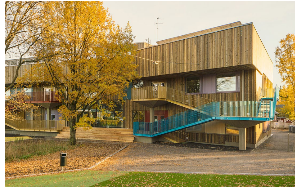
Vaaralanpuiston päiväkot i, Kivistö 2017. Kantavat rakenteet betonia, puujulkisivu. AFKS Arkkitehdit
