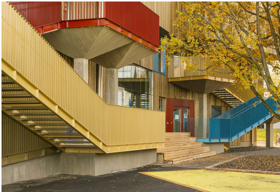
Vaaralanpuiston päiväkoti , Kivistö 2017. Kantavat rakenteet betonia, puujulkisivu. AFKS Arkkitehdit
