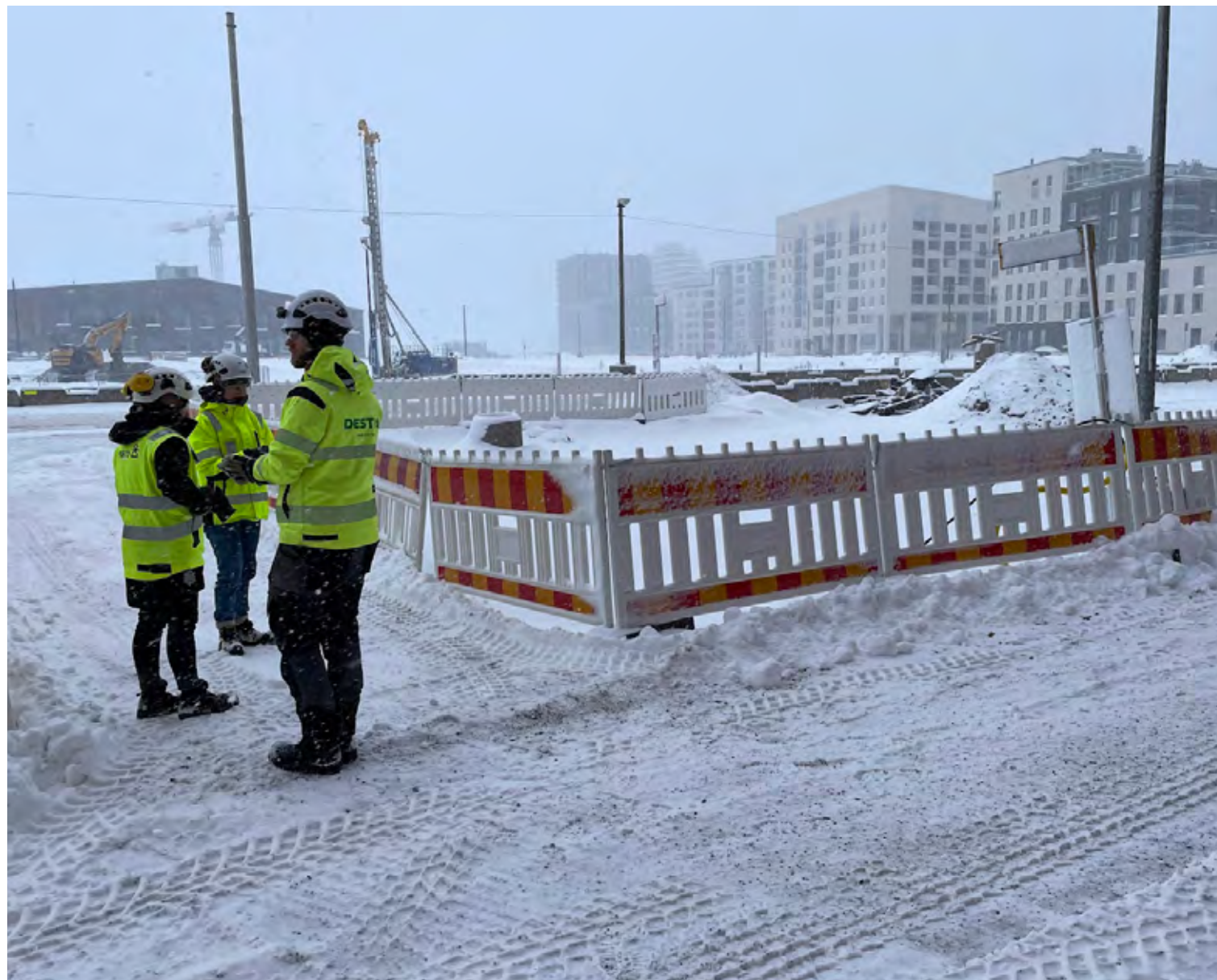
Kuva 6.28 Kalasatamasta Pasilaan -hankkeen työmaa. (Kuva: Ilari Jounila).
