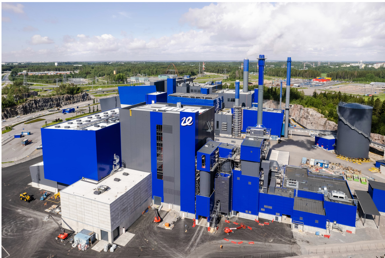
Bild: Vanda Energi Ab
