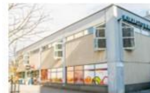
9. Pallastunturintien Liikekiinteistö Oy 1977
