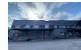
15. KOy Vantaan Helikopteritukikohta 2009
