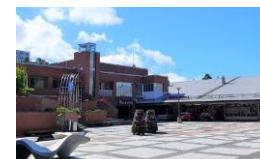
8. Hakopolun Liikekiinteistö Oy 1981
