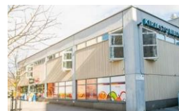
7. Pallastunturintien Liikekiinteistö Oy 1977
