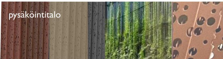
RAKENNUSMASSAN JAKAMINEN VISUAALISESTI PIENEMPIIN OSIIN, VERHOUS EAIM. REI'ITETTY 'VEKATTU' ALUMIINI, LEIKKISÄ AUKOTUS, JALUSTAN EROTTAMINEN VISUAALISESTI, KÖYNNÖSSEINÄT
