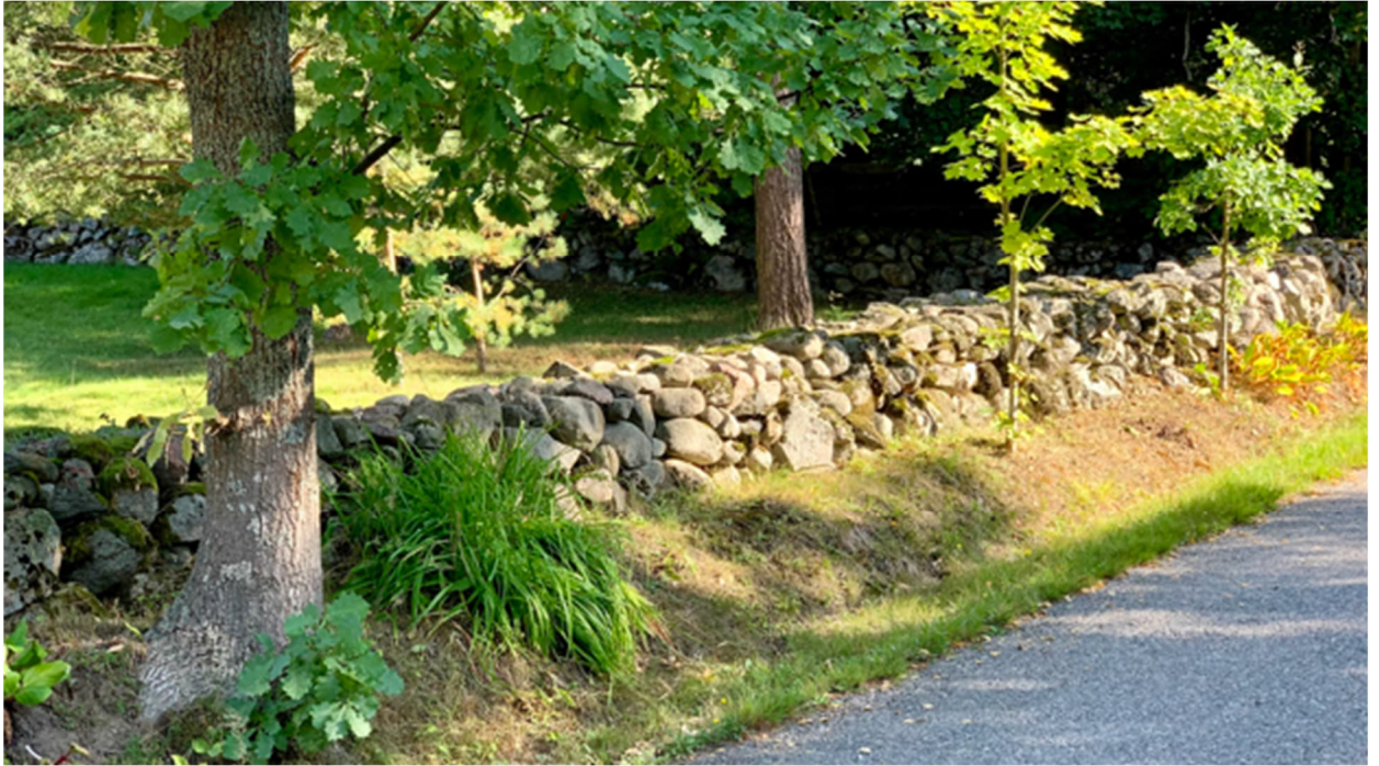
Palotie 10:n tonttia rajaava kivimuuri on rakennettu oikeudetta osin naapuritonttien puolelle ja on sammaloitunut. Kaupunginmuseo esitti lausunnossaan 3.9.2024 suojeltavaksi kivimuurin, mutta ei taloa.
