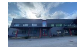
14. KOy Vantaan Helikopteritukikohta 2009
