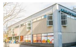
6. Pallastunturintien Liikekiinteistö Oy 1977
