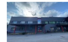
14. KOy Vantaan Helikopteritukikohta 2009
