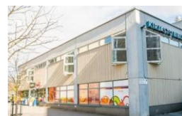
6. Pallastunturintien Liikekiinteistö Oy 1977
