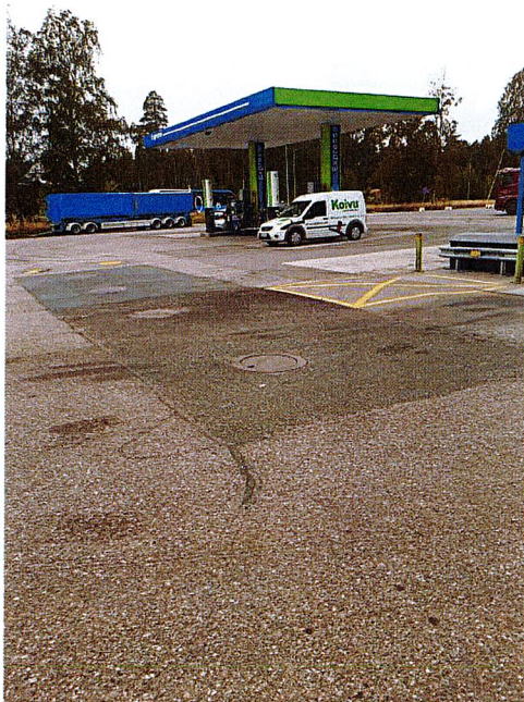
Kuva 4. Kuvassa etualalla säiliöalue ja sen vieressä pidätyslaatikko, jonka eteen on maalattu pysähtymiskieltomerkintä. Pidätyslaatikon vieressä näkyy jakelualueen betonilaattaa, jolle säiliöauto pysähtyy täyttäjien ajaksi.
