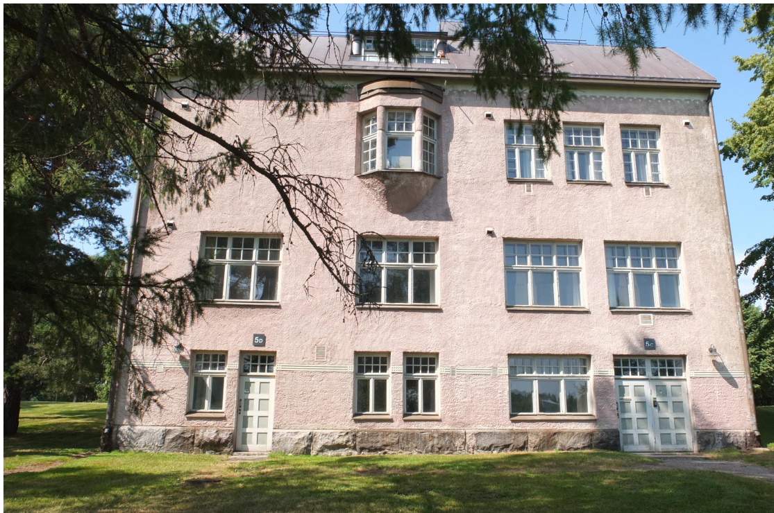
Metsäntutkimuslaitoksen toimintaan liittyvä rakennus, M. Koskinen 2013
