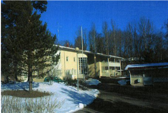
11. Vapaalantie 7 Vapaalantien suunnasta.
