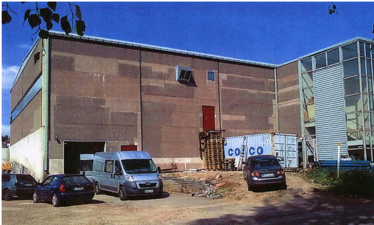
Nykytilanne Tiilitie 4:n tontilta Bölenraitin puolelta.
