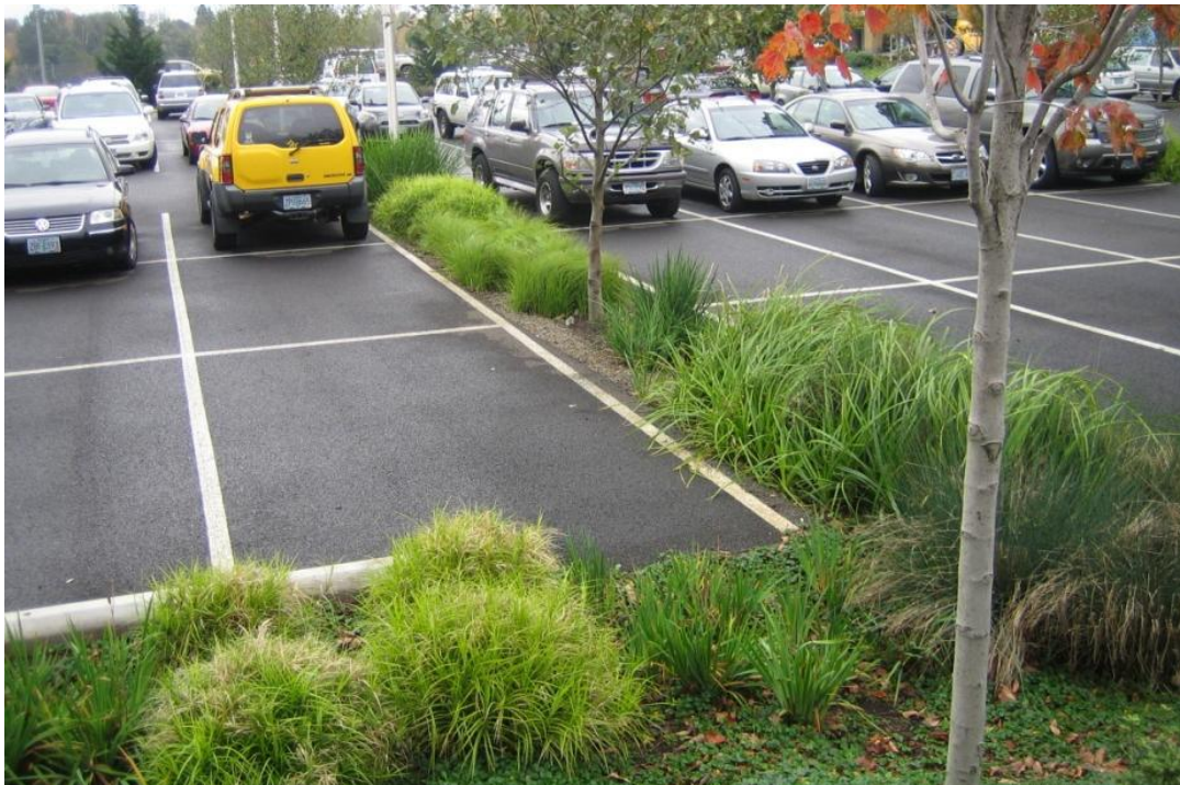
Kuva 4.2.3. Biopidätysrakenne Lähde: Ramboll Finland Oy
