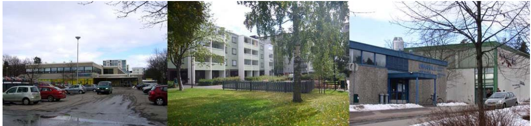
Kuva 4. Martinkeskus/ 70-luvulla rakennettuja asuinkerrostaloja/ uimahalli ja koulu (ennen koulun laajennusta)
