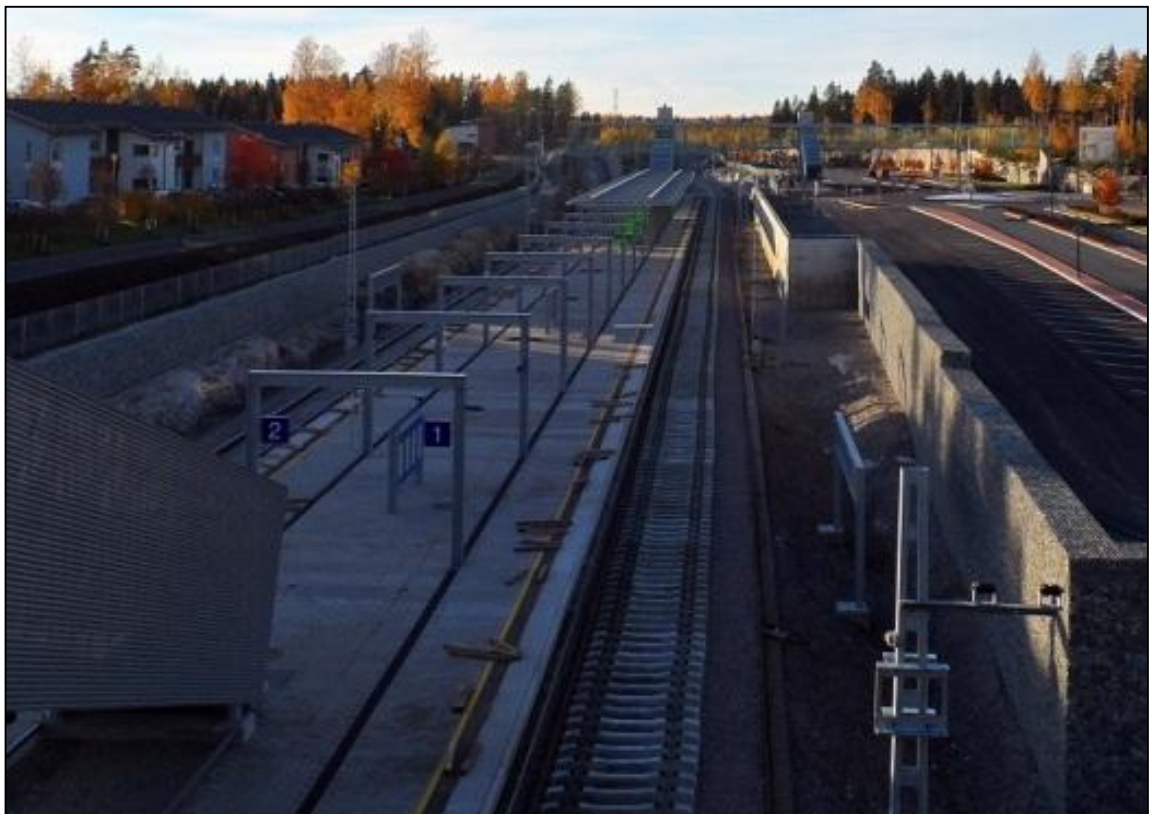
Kuva 1: Leinelän aseman kohdalla on radan pohjoisreunassa korkeahkot tukimuurit sekä näiden jatkona länteen kallioleikkaus
