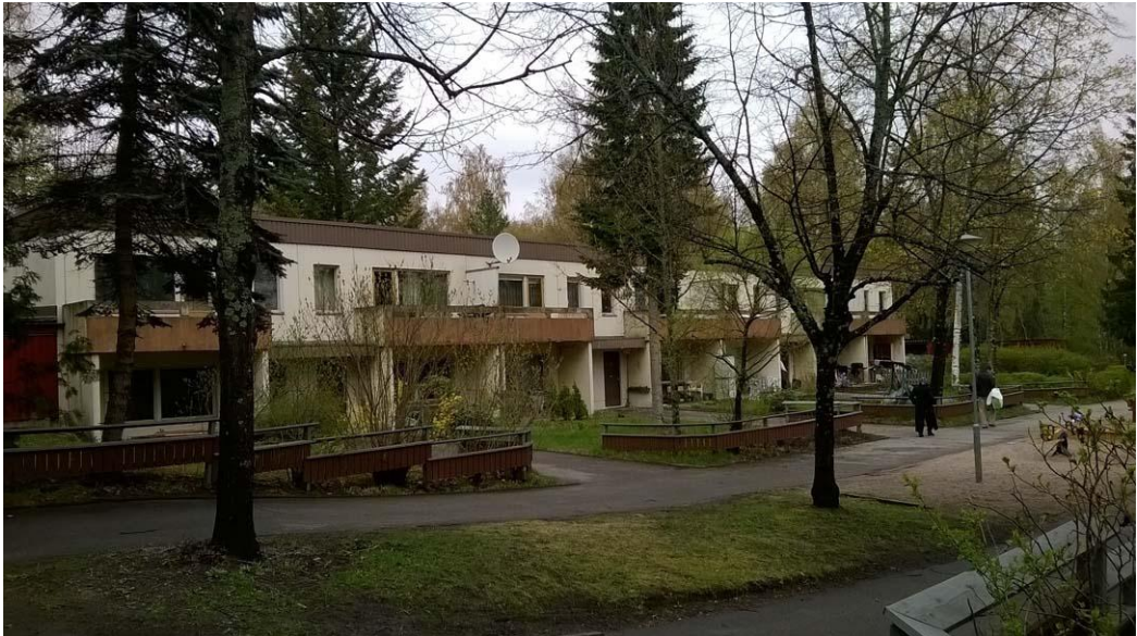
Kuva 5. purettavat 2-kerroksiset asuinrakennukset
