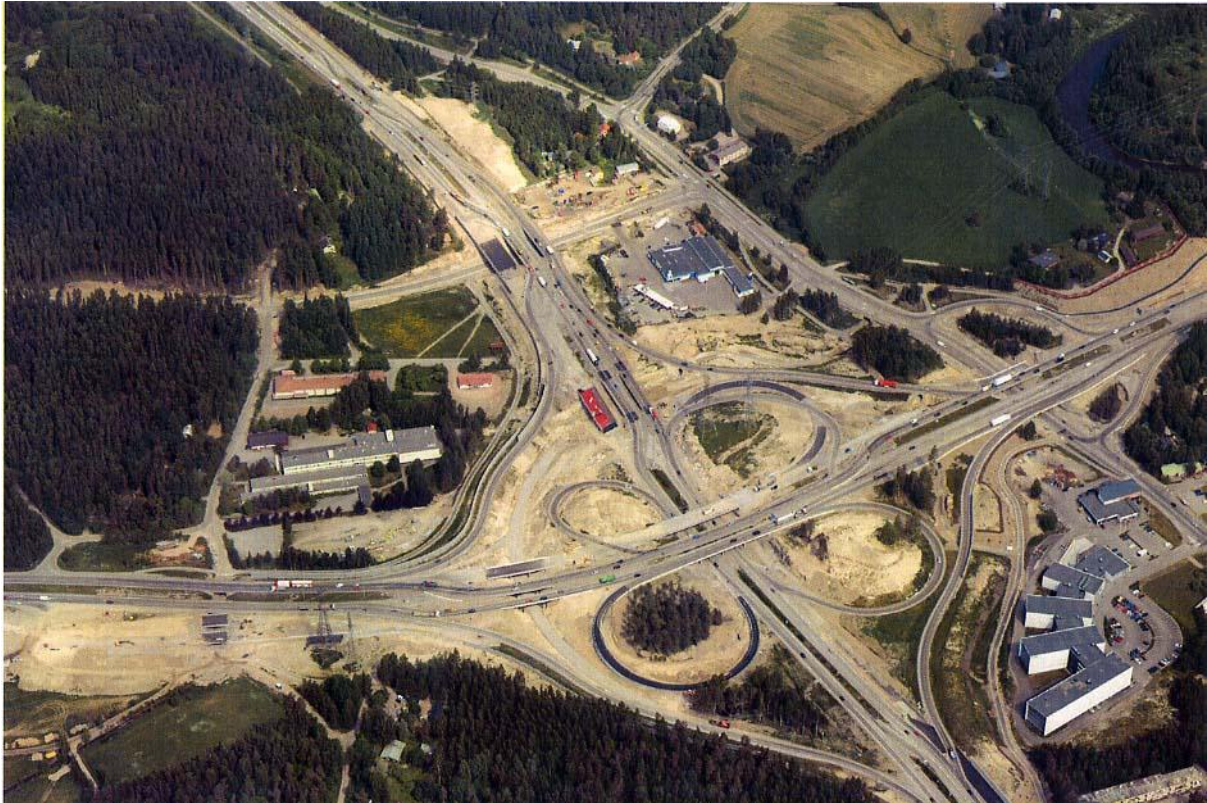
Kehä III:n ja Hämeenlinnanväylän liittymän rakennustyö kesällä 2011.
