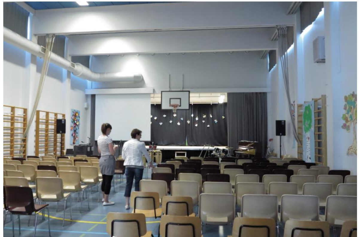
Voimistelusalissa on uusittu myös kattoakustointi ja näyttämöön liittyvät rakenteet ja varusteet. Kuitenkin palkki-pilarirakenne näkyy edelleen selkeästi.
