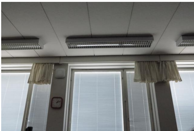
Lastulevyverhokotelot säilyneiden, korjattujen sisään- sisäänaukeavien ikkunoiden edessä. Ikkunoissa on säilynei- tä heloja.
