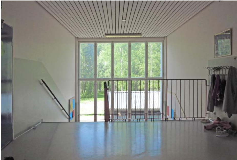
Valoisissa porrasauloissa on säilynyt koukustoja ja radiaattoreita. Myös maalatut puukatot ovat pääosin säilyneet (osin LVI-muutoksen yhteydessä korjattuina ja muutettuina). Edellinen aulojen yleisväritys oli lohenpunainen.
