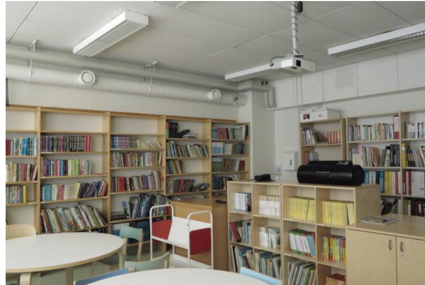
Vuoden 2003 LVI-korjauksen yhteydessä asennettuja poistoilmakanavia Katossa on maalattua halltex-levyä.
