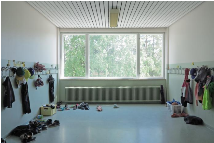
Valoisissa porrasauloissa on säilynyt koukustoja ja radiaattoreita. Myös maalatut puukatot ovat pääosin säilyneet (osin LVI-muutoksen yhteydessä korjattuina ja muutettuina). Edellinen aulojen yleisväritys oli lohenpunainen.
