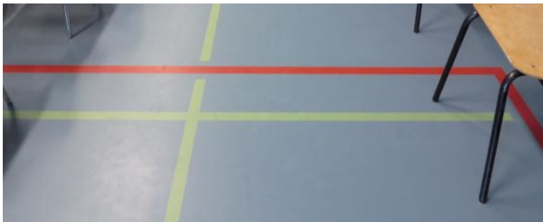
Ruokasalissa ja aulassa on säilynyt vanha, harmaa lino. Voimistelusalin ja aulan rajavyöhykkeellä ja voimistelusalissa on jouduttu kajoamaan rakenteisiin. Alapohjan vauriot johtivat korjaukseen, jonka yhteydessä salin lattiapinnoite vaihtui.
