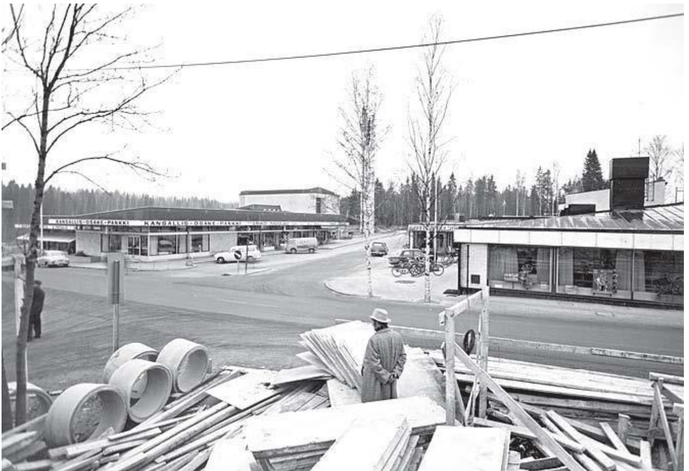
Korson keskustaa Merikotkantien ja Korsonpolun (entinen Korsontie) risteyksessä. Etualalla rakennustyömaa, jossa seisoo eläkkeellä oleva kunnanjohtaja Lauri Korpinen. Kuvausvuosi 1964. Kuva Mauno Mannelin Vantaan kaupunginmuseo.
