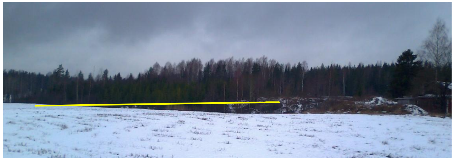
Kuva 18. Näkymä Luoteeseen ja hahmotettu täyttötaso (Ins. tsto Pohjatekniikka Oy, 2014 muokattu).
