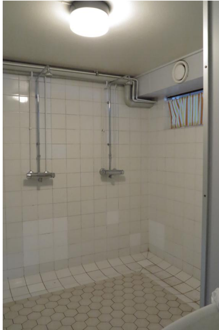
Voimistelusalin pesuhuoneen säilynyttä, paikattua vaaleaa laatoitusta
