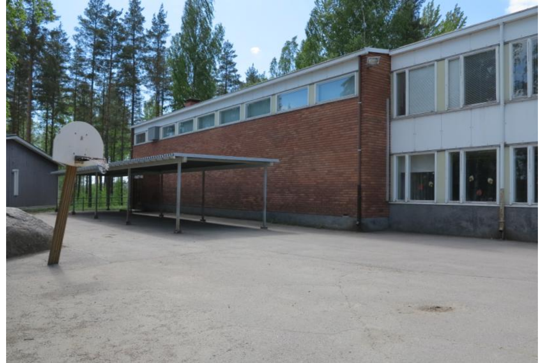
Lisätty katos sekä erityisesti väliaikainen koulu eivät täydennä koulurakennuksen ympäristöä luontevasti
