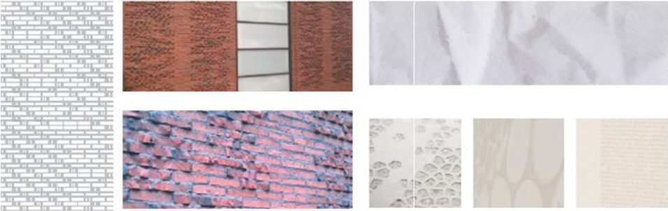
Referenssikuvaa Kampista osoittaa modernia tiilireliefitekniikkaa. Graafinen betoni mahdollistaa kuvioinnin tuomisen julkisivuun.
